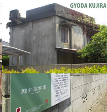
『鯨井家倉庫』現存する市内唯一の戦前の鉄骨コンクリート造の足袋蔵。行田市が表示版を設置されました。
